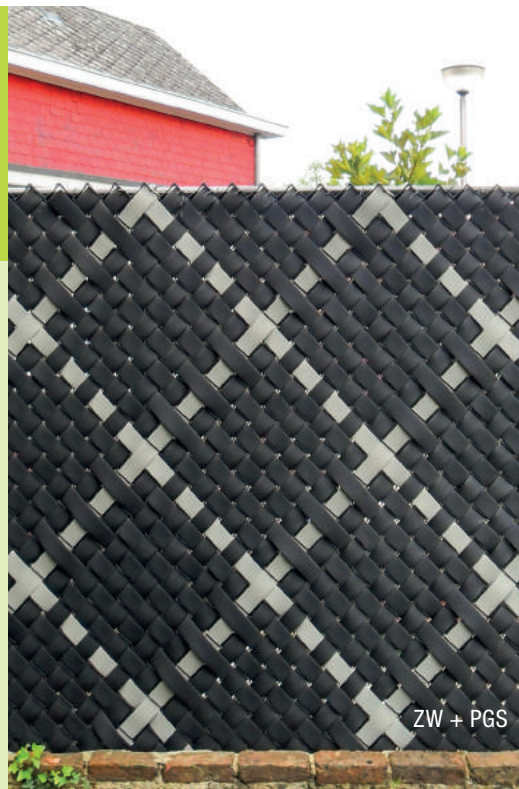
Zigzag-vlechtmethode Tissage zigzag
